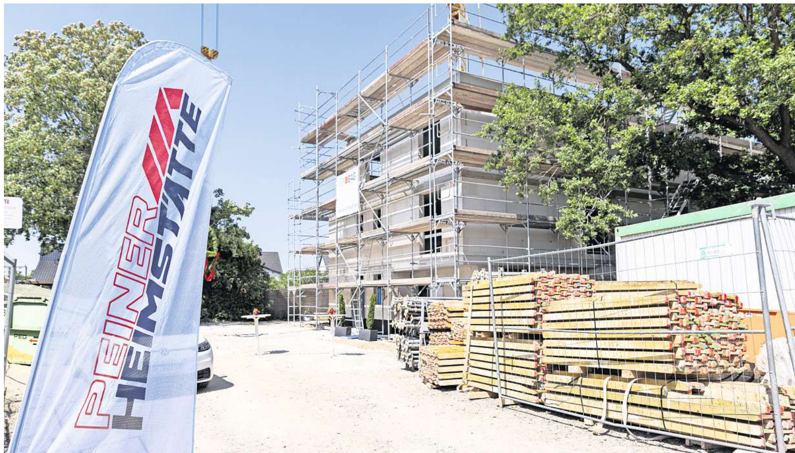
So sieht der Rohbau des neuen Gebäudes in Telgte aus.
